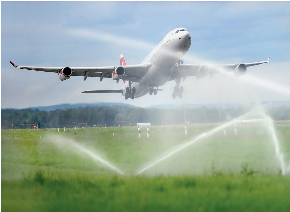
Die Verregnungsanlage am Flughafen Zürich im Betrieb
